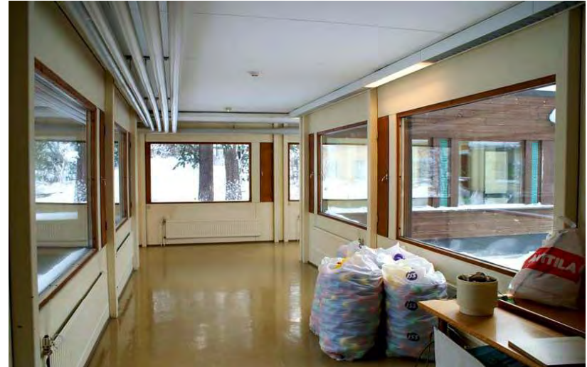
Kuva: Yhdyskäytävien risteykseen muodostuu laajoista lasipinnoista oma erityinen tilavaikutelma. Kuva otettu B-rakennuksen yhdyskäytävästä.
