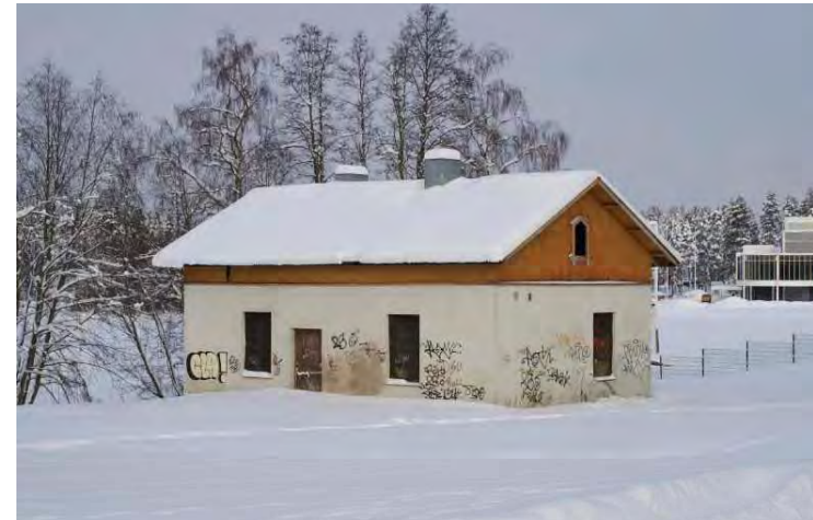
Kuva: Saunarakennuksen päädyissä ja eteläisellä sivulla on edelleen pystysuuntaiset ikkuna-aukot, mutta ikkunamalli ehti muuttua alkuperäisestä ennen aukkojen levyttämistä.
