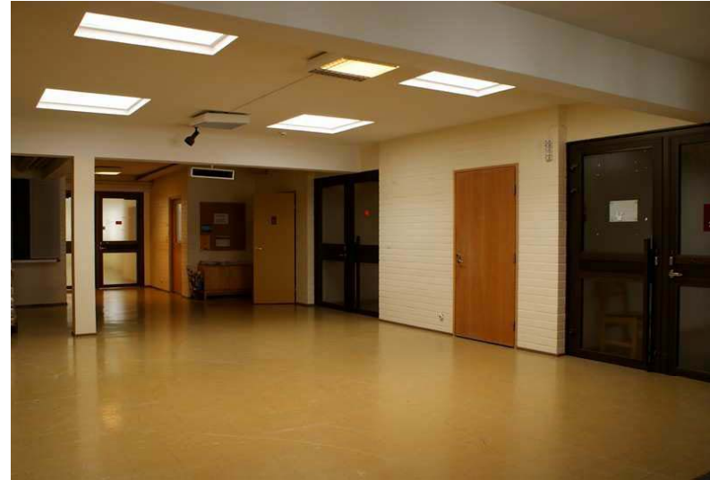
Kuva: Avarissa tiloissa, kuten aulassa, tulee näkyvillä rakennuksen pilaripalkkirunko. Katossa näkyvät valokuilut. Vihertävä lattia, tammiviilupintaiset sisäovet tehosteväreillä maalatuin vuorilistoin.
