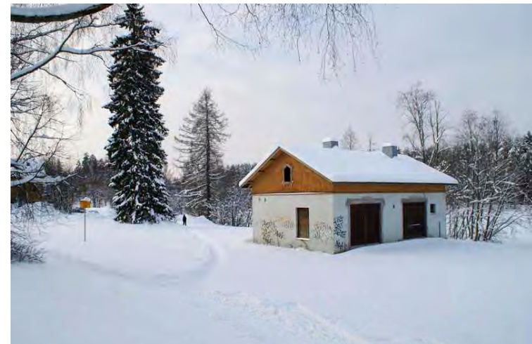
Kuva: Saunarakennus ja muutama vanha yksittäinen puistopuu. Uimalan puoleiselle seinälle on avattu isot oviaukot.
