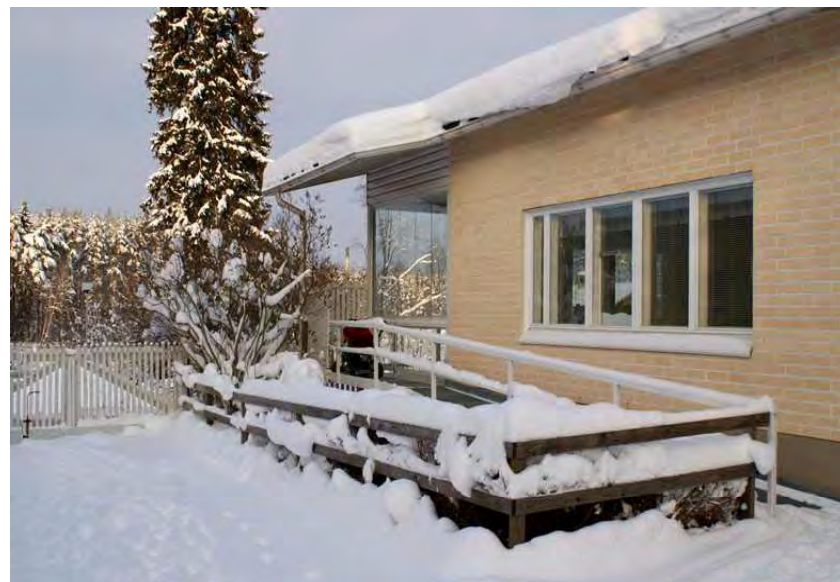
Kuva: C-rakennuksen lammenpuoleisessa päädyssä on lasitettu parveke.
