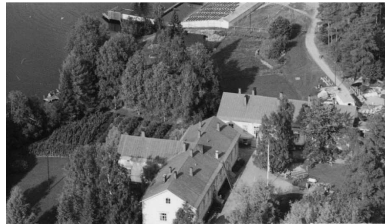
Kuva: Lähikuva A- ja B-rakennuksista. Ikkunat ja ulkoverhous 1890-luvun asussa. Sisäänkäynnit ilman suojaavaa katosta. / Suur-Savon museon valokuvakokoelma
